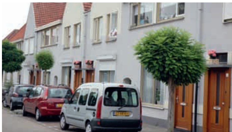
De woonwijk in Tilburg waar het gesmeerd renovatieteam te werk gaat
